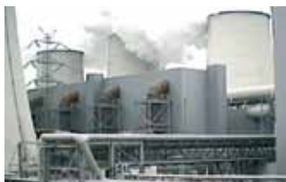
Überprüfung der Isolierung
