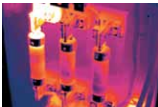
Überhitzte Verbindung
